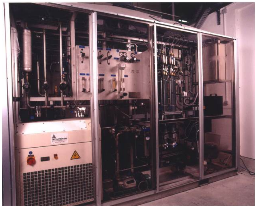
Premier système automatisé d'épuration du krypton/xénon (Moissy-Cramayel, France)
